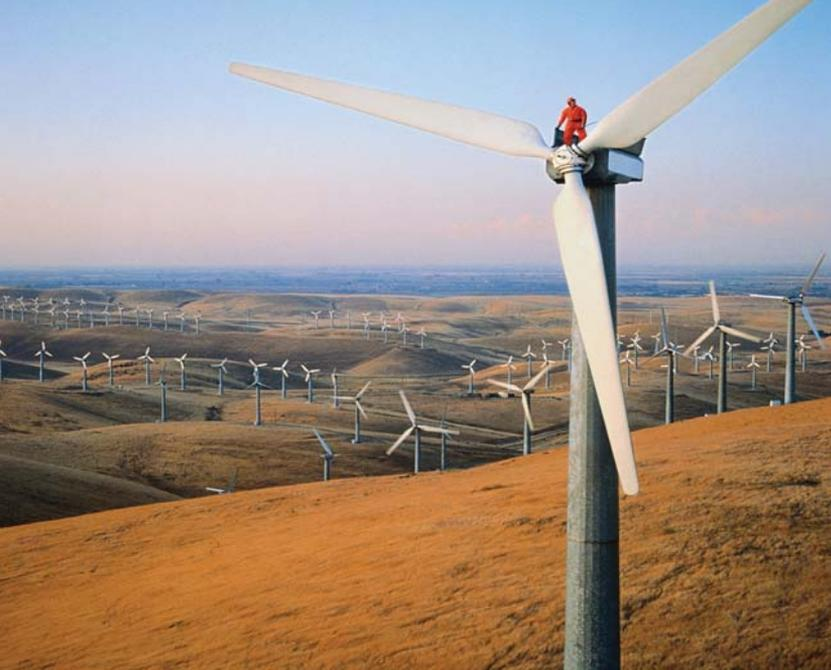
En una granja de viento, el aire en movimiento realiza trabajo sobre las aspas de los molinos, lo que hace girar las aspas y el rotor de un generador eléctrico. La energía se transfiere afuera del sistema del molino de viento mediante electricidad. (Billy Hustace/Getty Images)
